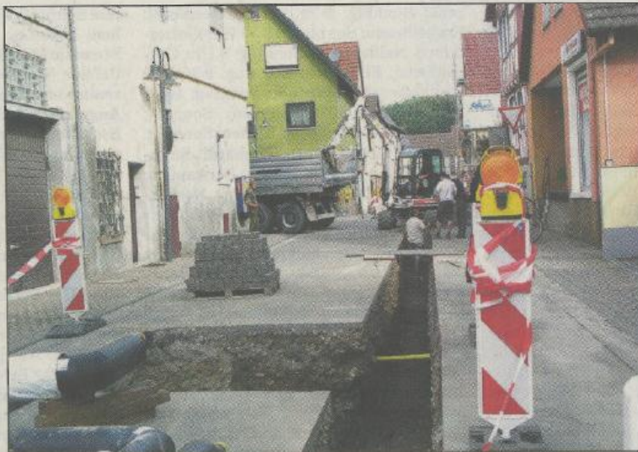
Viel wird in den Straßen im Ortskern von Hoffenheim derzeit gebuddelt, damit im kommenden Winter das Nahwärmeprojekt wirksam werden kann. Foto: Heß
