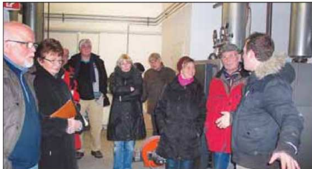
Geschäftsführer Markus Hess erläutert den Teilnehmern der Info-Veranstaltung technische Details einer Wärme-Übergabestation und beantwortet Fragen beim Rundgang durch das Heizwerk. Foto: Heß
